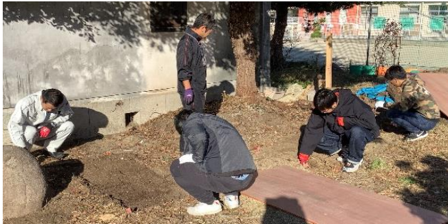
地面を平らにしたら柱を立てる穴掘りを開始！
